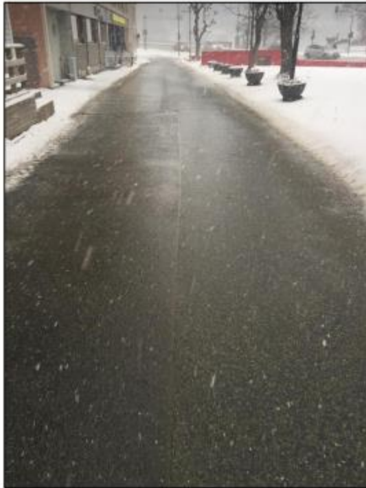
Asfalt (Optimal GsA)
